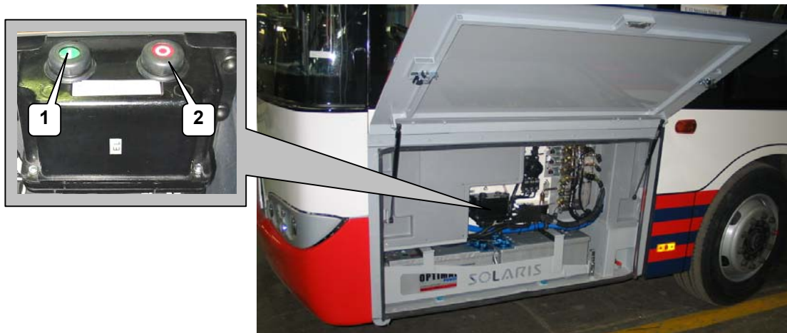
Rys. 27 Wyłącznik awaryjny w komorze akumulatorów: 1 – przycisk awaryjnego włączenia zasilania, 2 - przycisk awaryjnego wyłączenia zasilania
